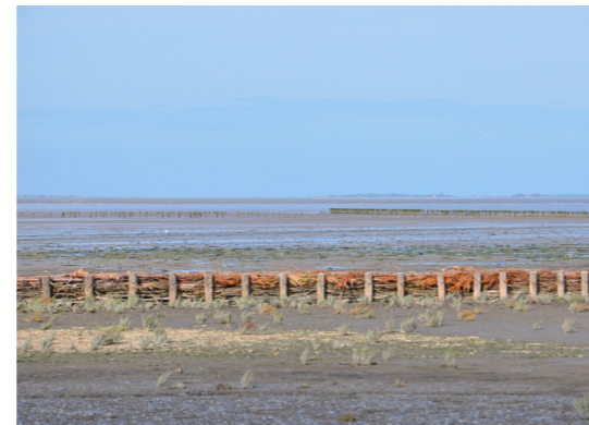
3.2. Rijshouten dammen van de landaanwinningswerken bij Noord-Friesland Buitendijks. Foto: Cora de Leeuw.
