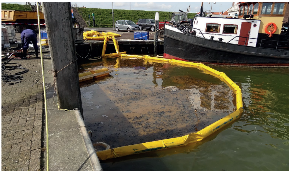
Figuur 14: Als gevolg van een lek in het brandstofsysteem op de kade van de haven van Oudeschild was een flinke hoeveelheid olie in de haven terechtgekomen. Door snel ingrijpen kon verdere verspreiding naar de Waddenzee worden voorkomen (foto: Rijkswaterstaat/Dennis van der Veen).
