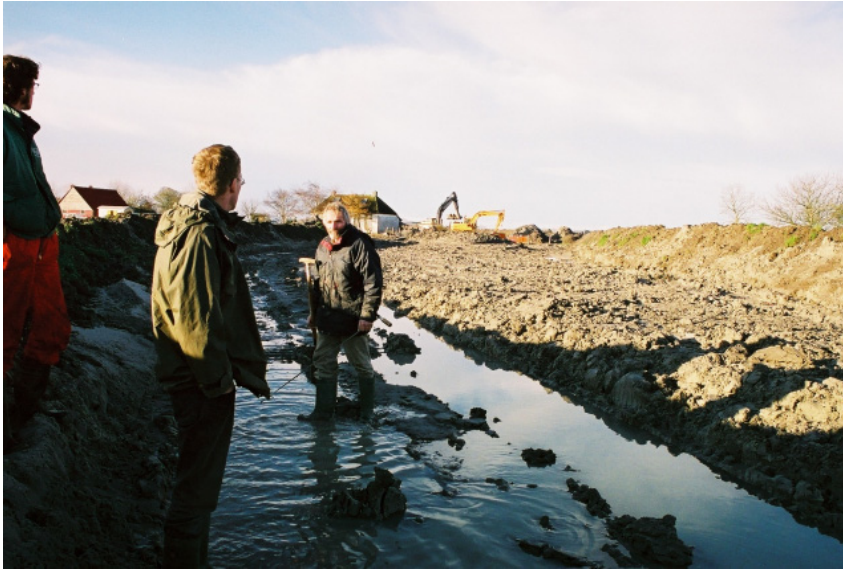
Figuur 21. Wegens de natte omstandigheden is de vernietiging van de bodemstructuur compleet.
