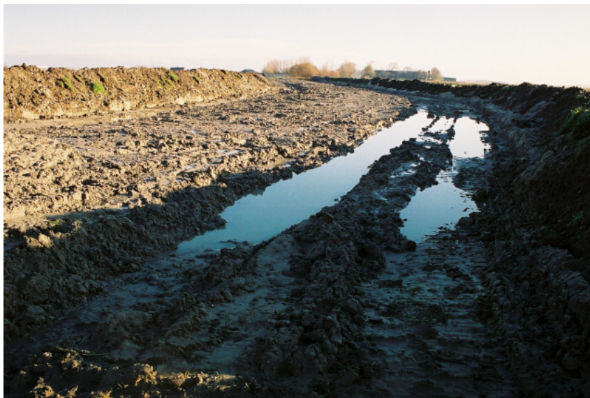
Figuur 20. Zeer brede vergraving voor installatie van een zoutleiding met een diameter van ca. 30 cm op perceel 'Kerkeland 3' van de Gerbranda State te Pietersbierum.
