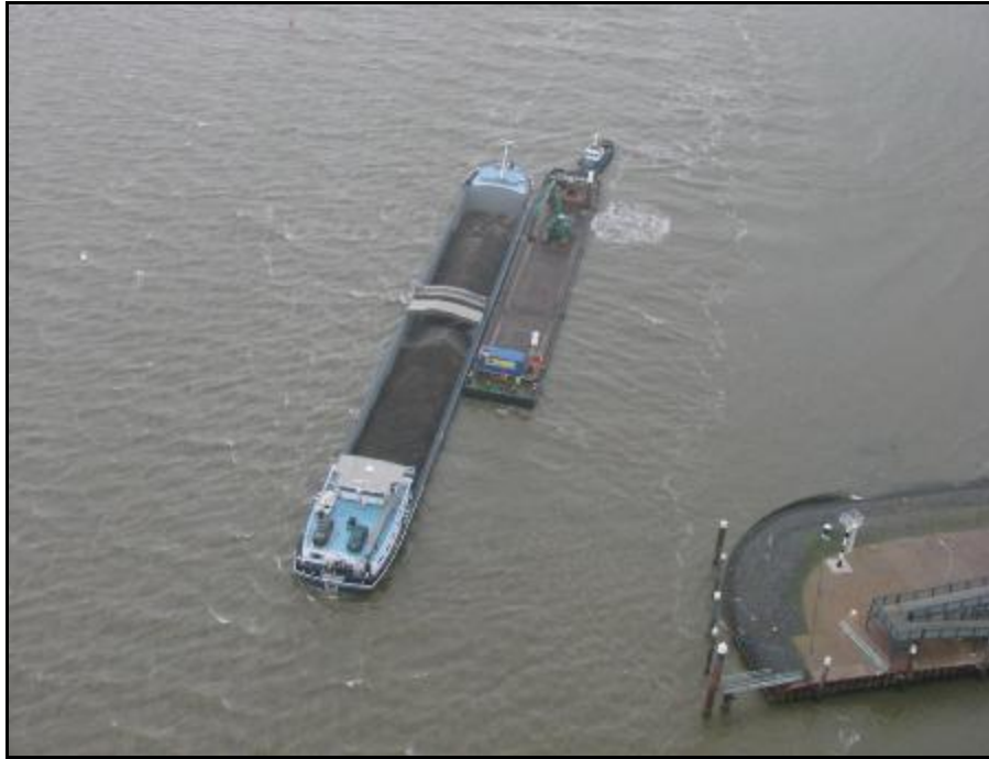
Foto 11: Aanbrengen staalslakken op de geulwand naast de veerdam. Foto Rijkswaterstaat
