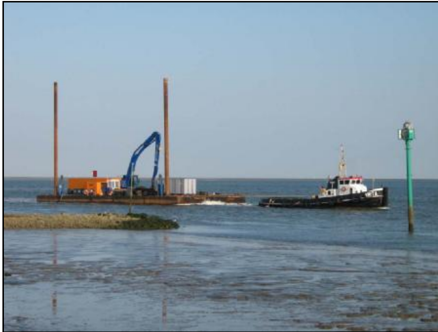
Foto 10: Werkponton met kraan wordt met een sleepboot naar de werklocatie gesleept. Foto Klaas van Dijk.
