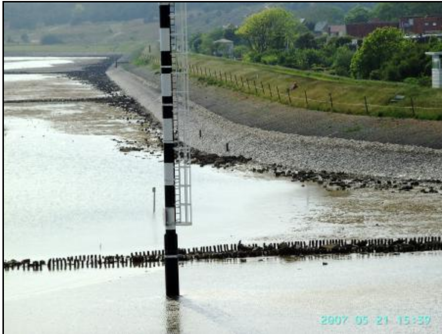
Foto 14: Waddendijk Vlieland met voorland en steenverdediging op het buitentalud. Foto A. Prakken
