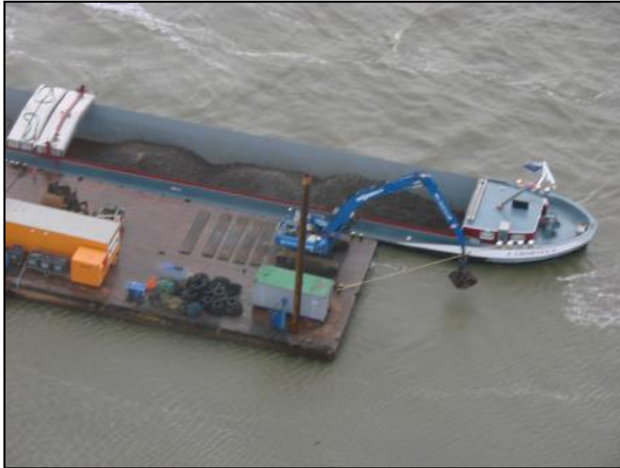
Foto 5: Aanbrengen staalslakken op de geulwand vanuit een schip. Foto Rijkswaterstaat
