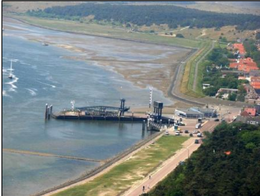
Foto 6: Wadkant Vlieland met dijk, taps verlopend voorland, stroomgeul, wadglooiing en strekdammen. Foto Rijkswaterstaat
