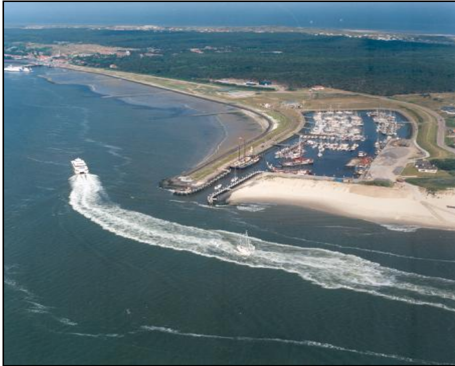
Foto 3: Oost punt Vlieland met havendammen, strekdammen op achtergrond en op voorgrond het Havenstrand, situatie 1999. Foto Rijkswaterstaat
