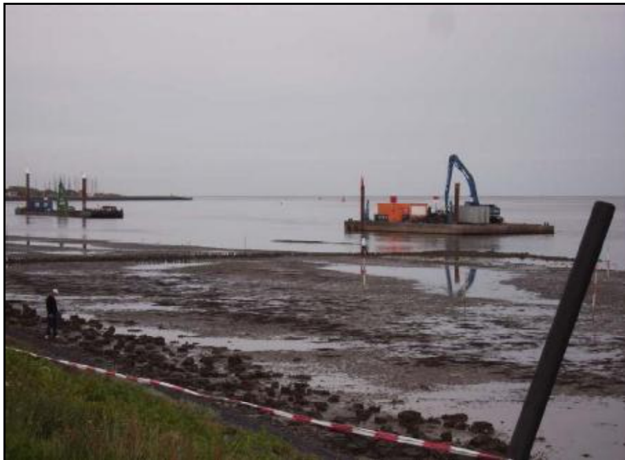
Foto 12: Voorland Waddendijk Vlieland met het werk in uitvoering. Foto Allix Brenninkmeijer
