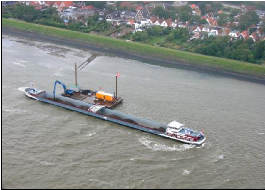
Foto 2: Kraan op werkponton lost staalslakken uit een schip. Foto Rijkswaterstaat
