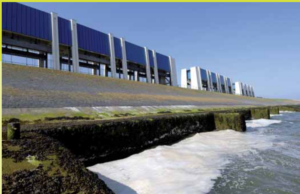
Lauwerssluizen bij Lauwersoog
